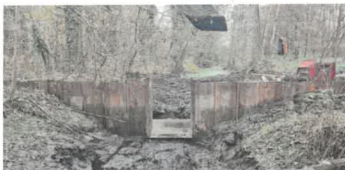
Ouvrage de même type posé sur la tourbière de Vred (PNR Scarpe-Escaut)
